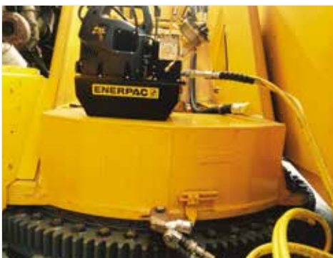
◀ Mantenimiento y montaje de grúa con llave dinamométrica S1500X accionada por bomba serie ZU4T.
